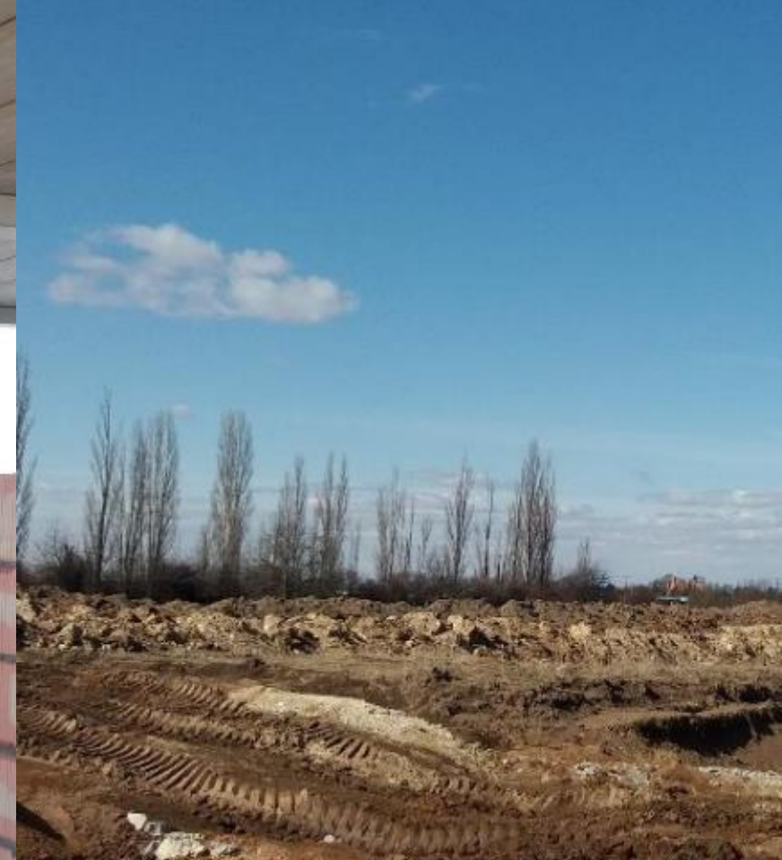
Uložení zeminy v areálu
