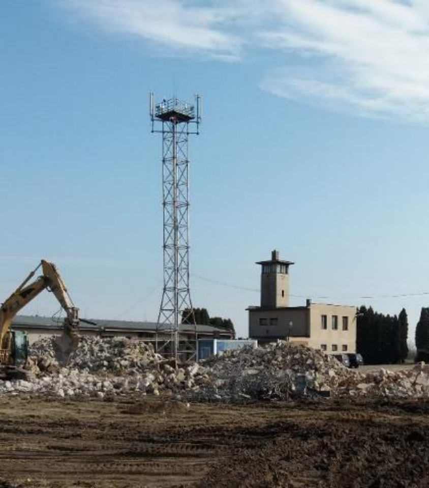
Zbourán seník a garáže, kde byl diesel generátor – po něm zůstala kontaminace
