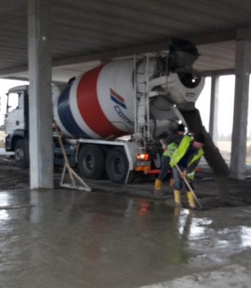
Podkladní beton a izolace (březen 2018)
